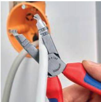
Schneiden von Kabeln bis Ø 13 mm
