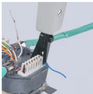
Eindrücken und Abschneiden des Kabels in einem Arbeitsgang
