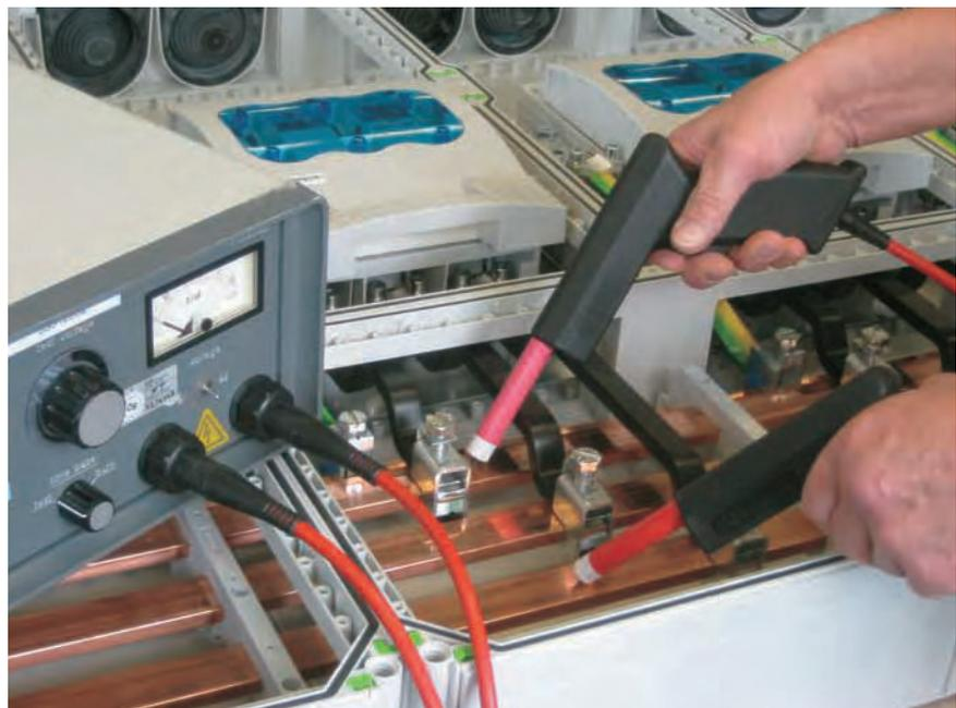
Als weitere Prüfung der Schaltanlage in der Werkstatt muss eine **Isolationsprüfung** durchgeführt werden. Mit der Isolationsprüfung wird die Isolation zwischen den aktiven Leitern und Körpern sowie die Isolation zwischen den Phasen überprüft.
