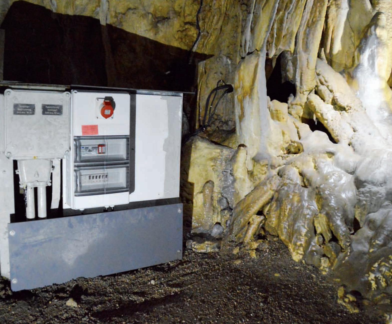
Bei annähernd 100% Luftfeuchtigkeit und 10 Grad Celsius Temperatur kommt empfindliche Elektronik häufig an ihre Grenzen. Um sie auch unter solchen Extrembedingungen sicher zu verwahren und Kondenswasser zu vermeiden nutzt man in der Iserlohner Dechenhöhle die AK Air Kleinverteiler mit integrierten Belüftungselementen.
