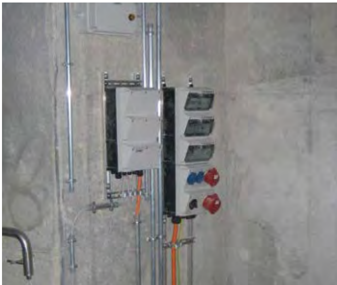
ÖBB (Österreichische Bundesbahn), Lainzer Tunnel, Wien, Österreich
