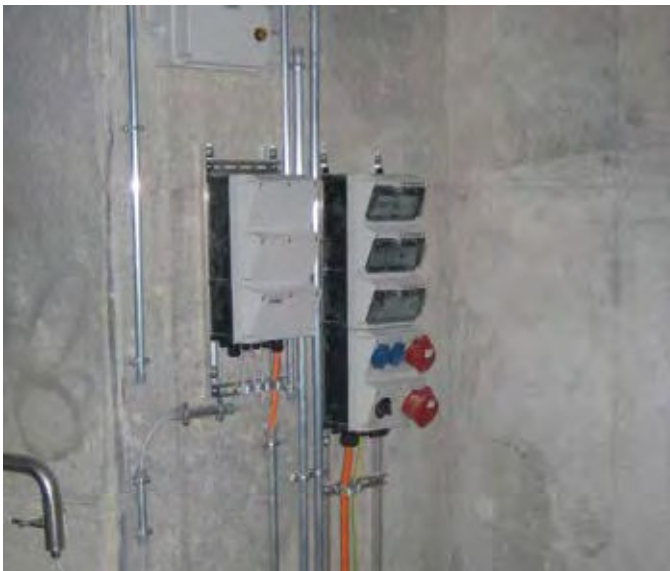
ÖBB (Österreichische Bundesbahn), Lainzer Tunnel, Wien, Österreich
