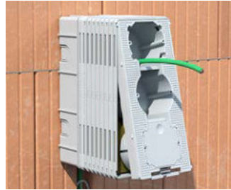
Den Kombinationseinsatz aufsetzen (Verschlussclip unten) und einrasten.
