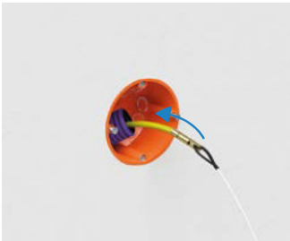
Die Einzugshilfe mit dem Kabelende verbinden und in das Leerrohr einziehen.
