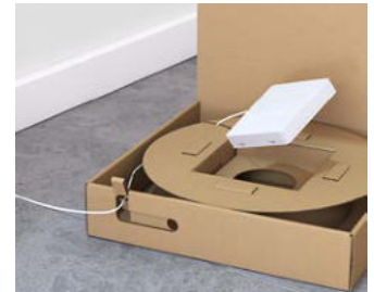
Am Ende den Teilnehmeranschluss aus der Kartonnage nehmen und die restliche Leitung einziehen.
