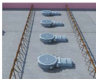
Erstelltes Fertigteilenelement mit integrierten HaloX®-Gehäusen wird auf der Betonbaustelle verlegt.
