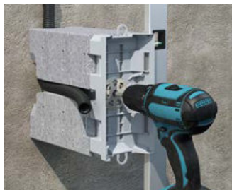
Geräteträger an die Wand halten, ausrichten und mit Dübel befestigen.
