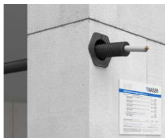
Wanddurchführung durch Brandschutzwand aus Kalksandstein.
