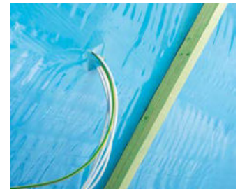
Die Leitungen werden durch die Luftdichtung des Gebäudes geführt. Diese Durchführung muss dauerhaft luftdicht verschlossen werden.
