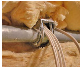
Zusätzlich muss der Mast, der den Parabolspiegel hält, in den Potentialausgleich einbezogen werden.
