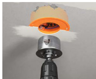
Erstellen einer runden Installationsöffnung (max. Ø 100 mm) mittels KAISER-Fräser...
