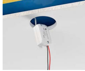
Installation des Betriebsgerätes (Treibers).
