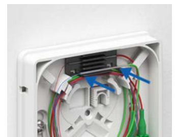
Spleißarbeit durchführen und Crimp Spleißschutz im Halter ablegen.
