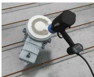
Montage des einteiligen Gehäuses mit Mineralfaserplatte...
