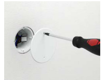
Mit Brandschutzdeckel (Art.-Nr. 1184-94) auch als Verbindungsdose verwendbar.
