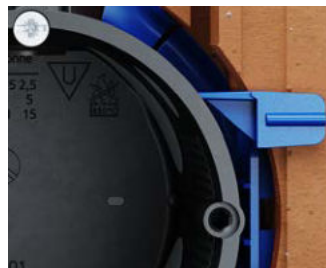
Tiefenanschlag zur Sicherstellung der Mindestputzstärke.
