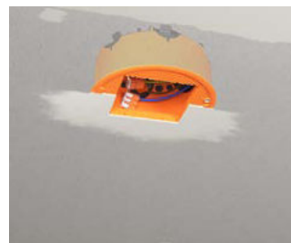
...oder einer eckigen Installationsöffnung (max. 75 x 75 mm), z. B. mit einer Stichsäge.
