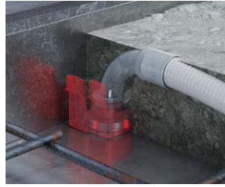
...den neuen Wand-Decken-Übergänge 90°,...
