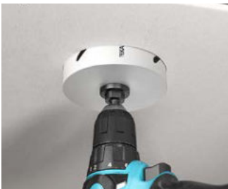
Einbauöffnung Ø 120 mm mit KAISER BASIC Fräser (Art.-Nr. 1084-20) erstellen.
