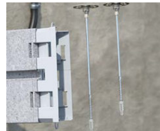
Schraubdübel den Seitenlaschen entnehmen. Beachten Sie die unterschiedlichen Längen!
