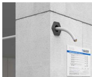
Wanddurchführung durch Brandschutzwand aus Kalksandstein.
