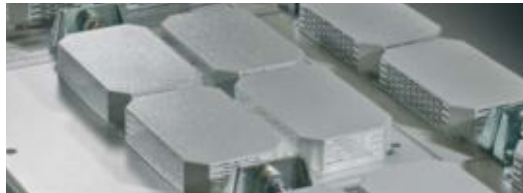
Lüftungshauben im Dachbereich
