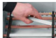
Sammelschienenabdeckung zum Isolieren
