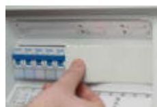
Abdeckstreifen für nicht genutzte Geräteausschnitte
