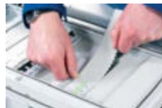
Geräteausschnitte berührungssicher abdecken
