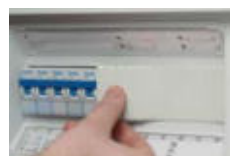
Abdeckstreifen für nicht genutzte Geräteausschnitte
