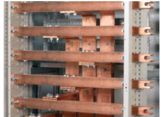
Sammelschienensystem 2000 - 5000 A
