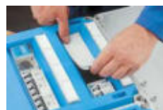
Geräteausschnitte berührungssicher abdecken
