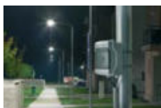
Beleuchtungssteuerung einer Wohnanlage mit Parkplatz
