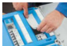
Geräteausschnitte berührungssicher abdecken
