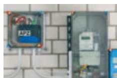
Gehäuse für Kommunikationseinrichtungen zur Übertragung von Messdaten
