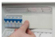
Abdeckstreifen für nicht genutzte Geräteausschnitte
