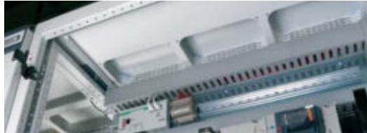
Lüftungshauben im Dachbereich
