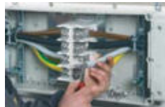
Leiterende muss sorgfältig durch Schaben von der Oxidschicht gesäubert werden.
