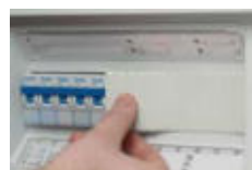
Abdeckstreifen für nicht genutzte Geräteausschnitte
