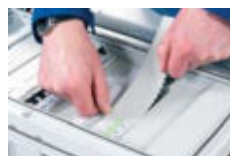
Geräteausschnitte berührungssicher abdecken
