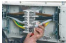
Leiterende muss sorgfältig durch Schaben von der Oxidschicht gesäubert werden.
