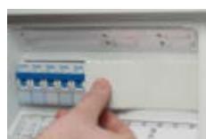
Abdeckstreifen für nicht genutzte Geräteausschnitte
