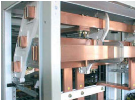
Sammelschienensystem 1250 - 2500 A
