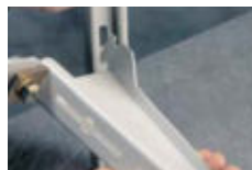
Schritt 1: Einsetzen der unteren Halterung ins C-Profil
