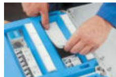
Geräteausschnitte berührungssicher abdecken
