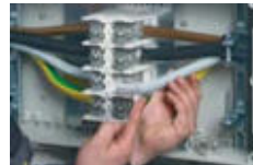
Leiterende mit säure- und alkalifreiem Fett einreiben und sofort anschließen
