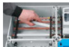
Sammelschienen-abdeckung zum Isolieren
