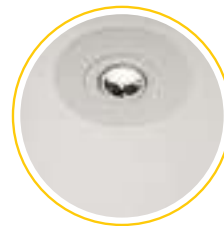
6. Neue Deckeneinbauleuchte in Reduzierring platziert.
