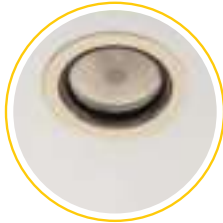
1. Alte Deckeneinbauleuchte mit größerem Deckenausschnitt.
