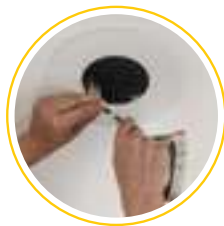
5. Elektrischer Anschluss und Installation der neuen Deckeneinbauleuchte.
