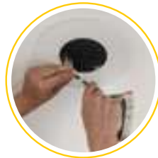
5. Elektrischer Anschluss und Installation der neuen Deckeneinbauleuchte.
