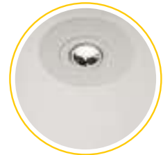
6. Neue Deckeneinbauleuchte in Reduzierring platziert.
