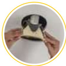
2. Deinstallation der alten Deckeneinbauleuchte.
