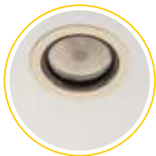
1. Alte Deckeneinbauleuchte mit größerem Deckenausschnitt.
