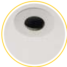
4. Reduzierring eingebaut. Größerer Deckenausschnitt gänzlich abgedeckt.
