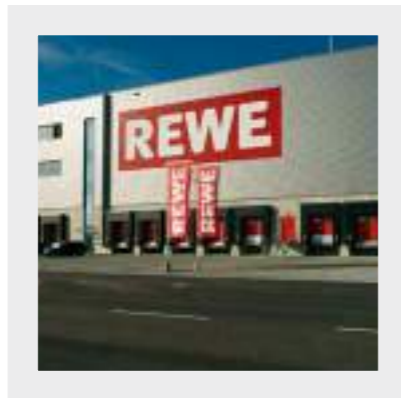
Logistikzentrum von REWE setzt Sicherheitstechnik von ASSA ABLOY ein.
