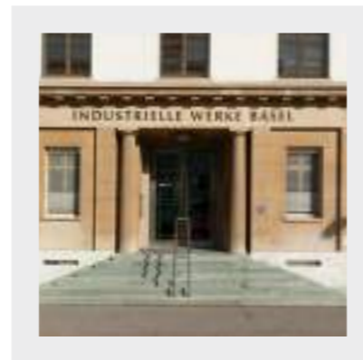
Die Industriellen Werke Basel (IWB) sorgen mit VERSO®CLIQ für Sicherheit.
